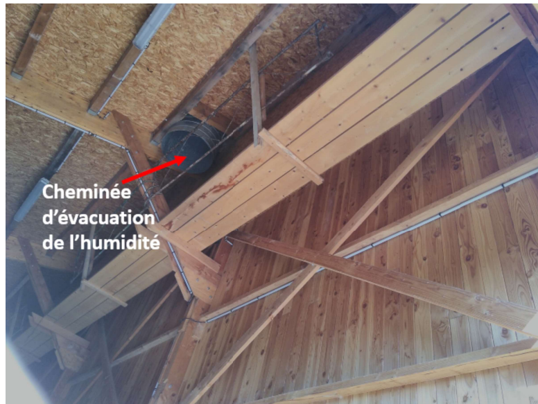
Illustration 8: Cheminée - vue depuis l'intérieur
