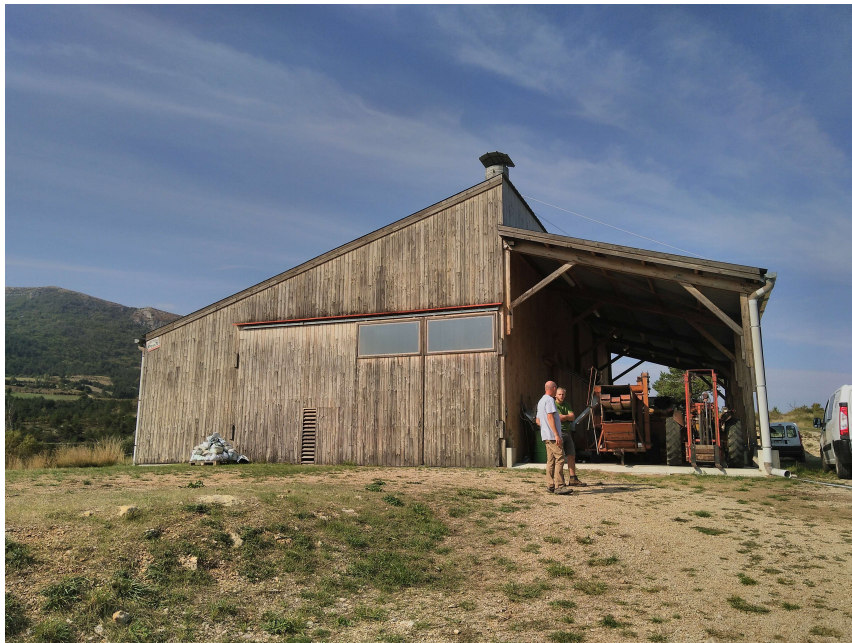
Illustration 10: Séchoir solaire - vue côté Est
