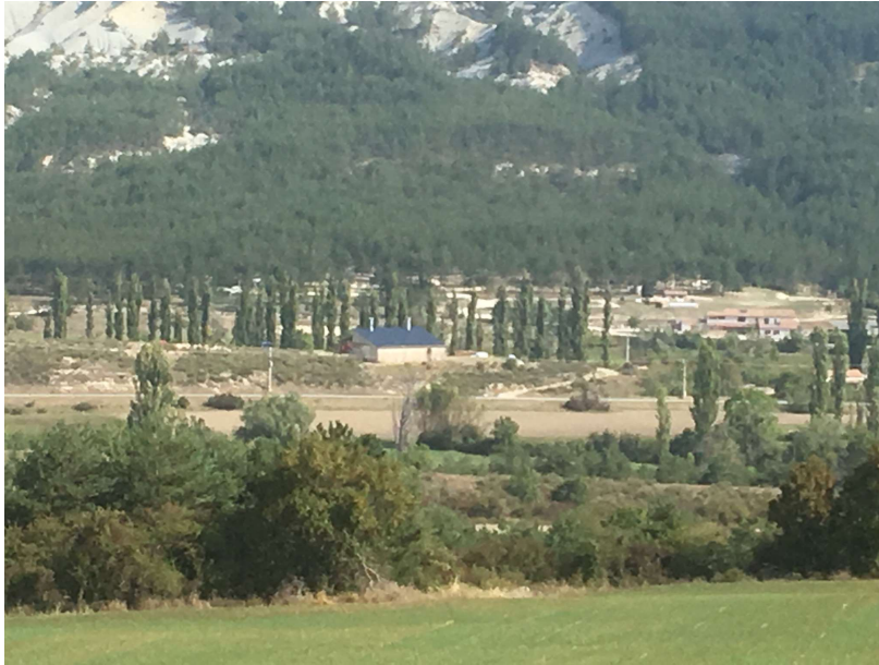
Illustration 2: Le séchoir solaire vu de loin
