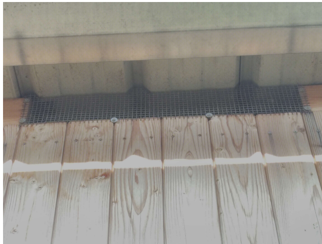
Illustration 3: Grille : entrée de l'air extérieur
